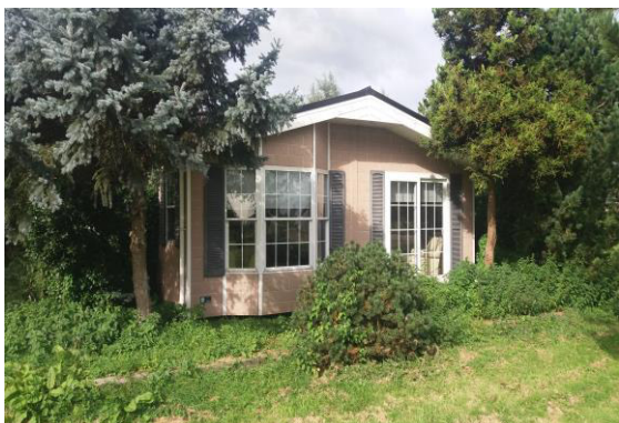
Foto 1: Geïntervieweerde woning vanuit oostelijke richting gezien. (geen asbest waargenomen)
