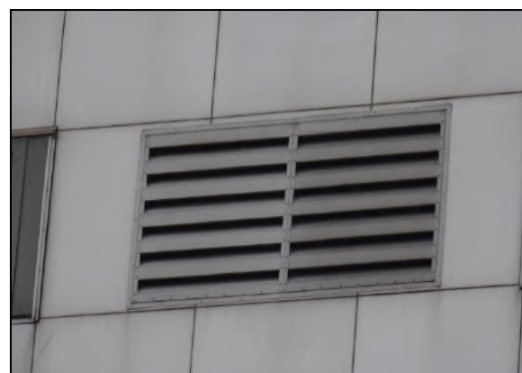
Figuur 8. Toegangsmogelijkheid tot flat niet aanwezig.
