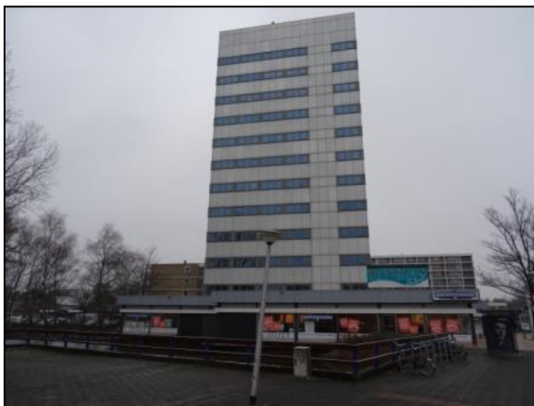
Figuur 3. Overzicht onderzoekslocatie vanaf de Oranjesbaan.
