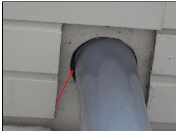
Figuur 7. Toegang tot overstek.
