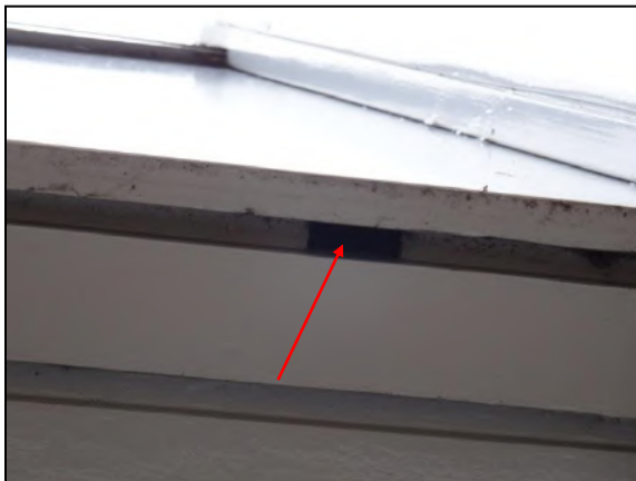
Figuur 6. Toegang tot overstek.
