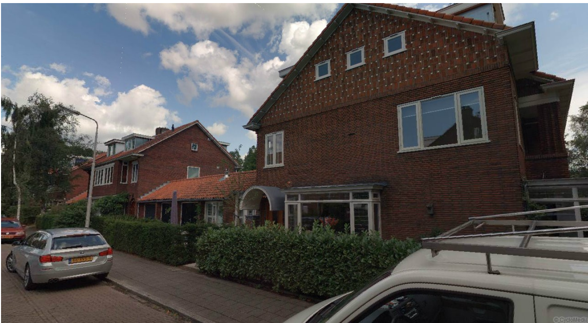
Afbeelding 4: Kopgevel Hoek Claes Persijnlaan – De Ruwiellaan
