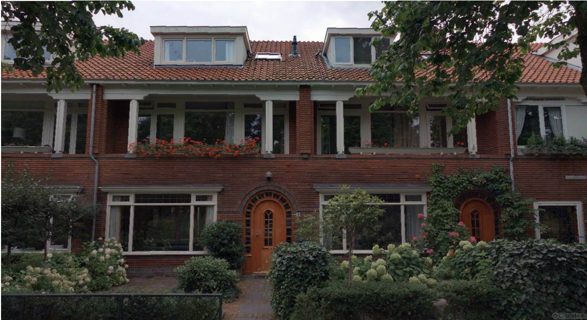
Afbeelding 3: Voorgevel woning Dijkgravenlaan 18
