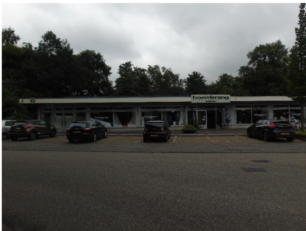
Figuur 2 Het andere perceel is bebouwd met een kringloopwinkel, welke gesaneerd wordt in de beoogde ontwikkeling.
