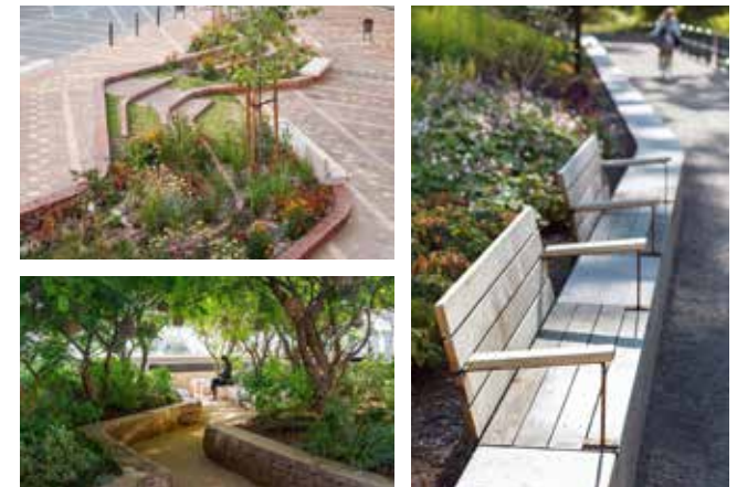
Gemetselde muurtjes, kaderen de ruimte en functioneren tevens als zitelementen
